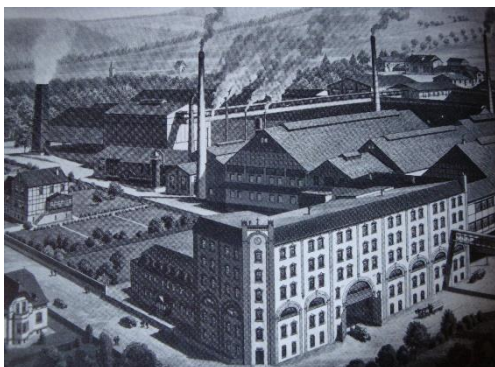
ドイツの創成期ガラス製造工場
